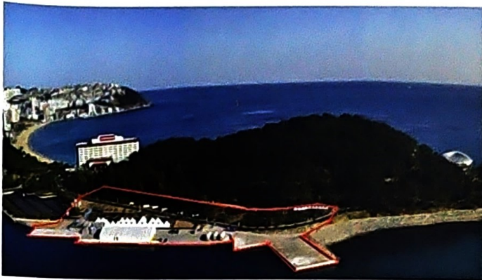
해운대 동백섬 군 부두시설 부산시민 품으로 돌아온다. 시는 군 부두를 포함한 동백섬 전체를 시민 친수공간으로 재정비, 해양관광자원으로 활용키로 했다.
