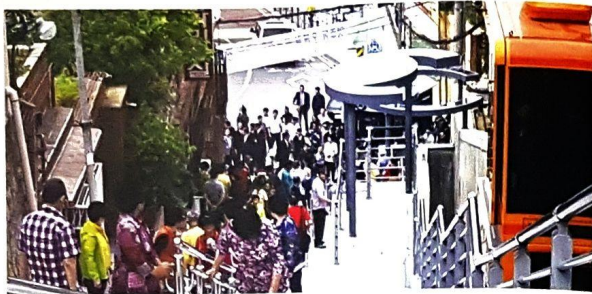
부산이 전국에서 처음 중구 영주동 산복도로에 설치한 주민복지형 모노레일 승강기
