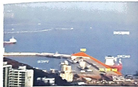
▲ 동삼동 국제크루즈부두 확장공사 현장
